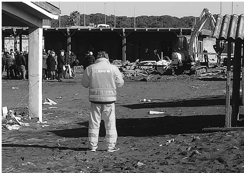
Demolizione stabilimento "Arca" - 4.3.2020
