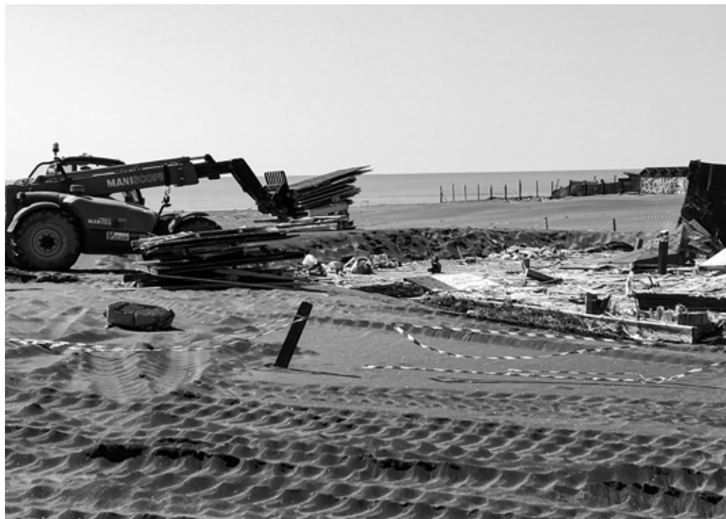
Demolizione chiosco Spiaggia SPQR (ex Amanusa)
