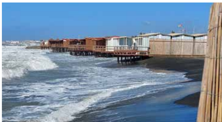
Stabilimento Venezia (settembre 2022)
