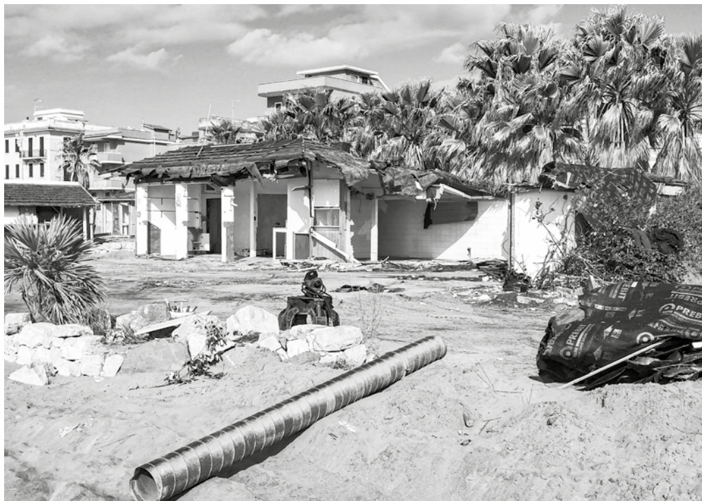
Demolizione Chiosco Faber Beach
