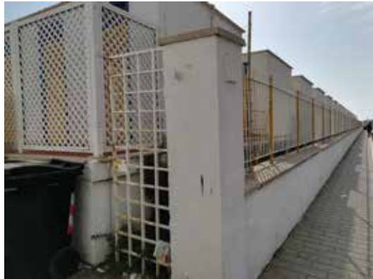
Stabilimento Lido (esterno)
